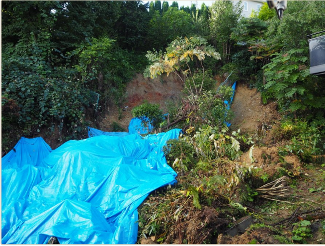
崩れた裏山の斜面。赤土がむき出しになり、応急でブルーシートで覆った。
