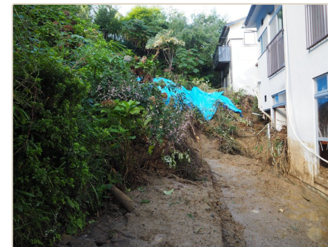
母屋のさきまで流れ込んだ土砂と、泥まみれになった外壁。
