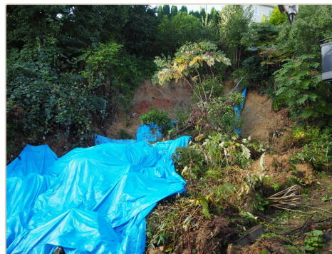
崩れた裏山の斜面。赤土がむき出しになり、応急でブルーシートで覆った。
